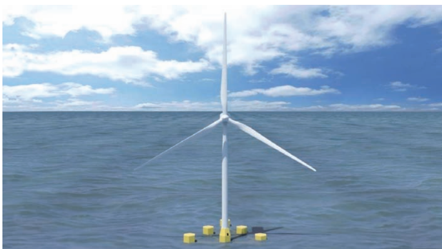
> Plataforma semi-sumergible de acero HiveWind con aerogenerador de gran potencia (Fuente: Hive Wind Energy S.L.)
